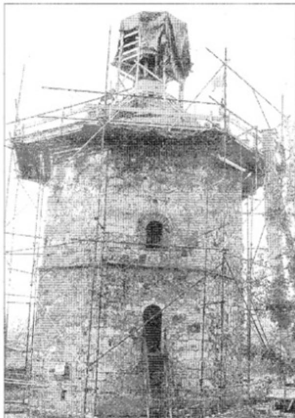
La toiture du colombier va être recouverte de tuiles de Bourgogne et le campanile d'ardoises d'Angers.
